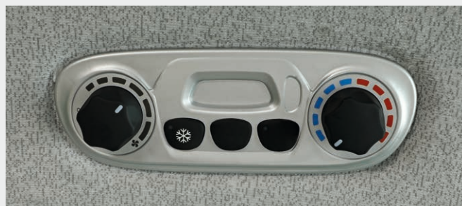
Climatisation à commande manuelle.
