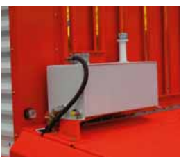
Centrale hydraulique pour le tapis de déchargement
